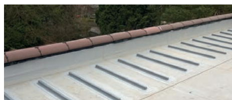
EJOBAR umístěný správně kolmo k hydroizolačnímu pásu.
