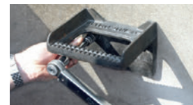
6. Nasadte kotvu a momentovým klíčem utáhněte na T_{inst} = 25 \text{ Nm} .
