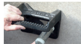
3. Otvorem v nášlapném stupni prostrčte kotvu a nasadte do otvoru.
