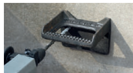
5. Vyvrtejte druhý otvor a vyčistěte. Nášlapný stupeň slouží jako vrtací šablona.
