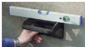
4. Vyrovnajte nášlapný stupeň.
