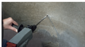
1. Vyvrtejte otvor.
